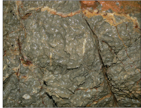
Obr. 7. Korózne jamky na stenách vstupnej priepasti. Foto: J. Psotka Fig. 7. Corrosion pits on the walls of the Entrance shaft. Photo: J. Psotka
