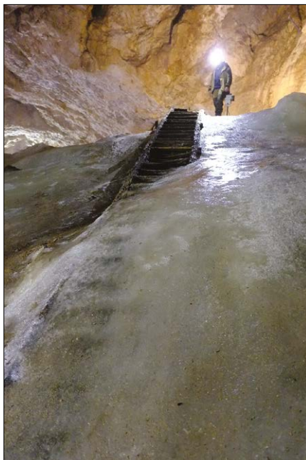
Obr. 2. Dodnes zachovaná časť dreveného schodiska vo Veľkej sieni, ktoré bolo súčasťou pôvodnej prehliadkovej trasy. Schody boli posýpané dreveným rezom proti pošmyknutiu. Foto: P. Holúbek
