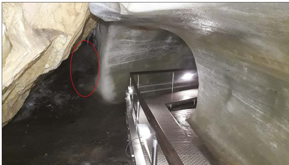
Obr. 15. Zaľadnené ústie pôvodnej prerážky v Ruffinyho koridore vedúcej do Pekla označené červenou elipsou. Vedľa ústie dodnes používaného tunela vyrazeného v roku 1968. Foto: M. Kudla
