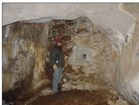
Obr. 5. Ochranný múr s dvierkami na konci Výskumnej chodby. Foto: Z. Višňovská Fig. 5. Protective wall with a door at the end of the Výskumná chodba Corridor. Photo: Z. Višňovská
