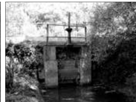
Obr. 11. Výpustný objekt zo severnej časti prírodnej rezervácie. Foto P. Hronček
