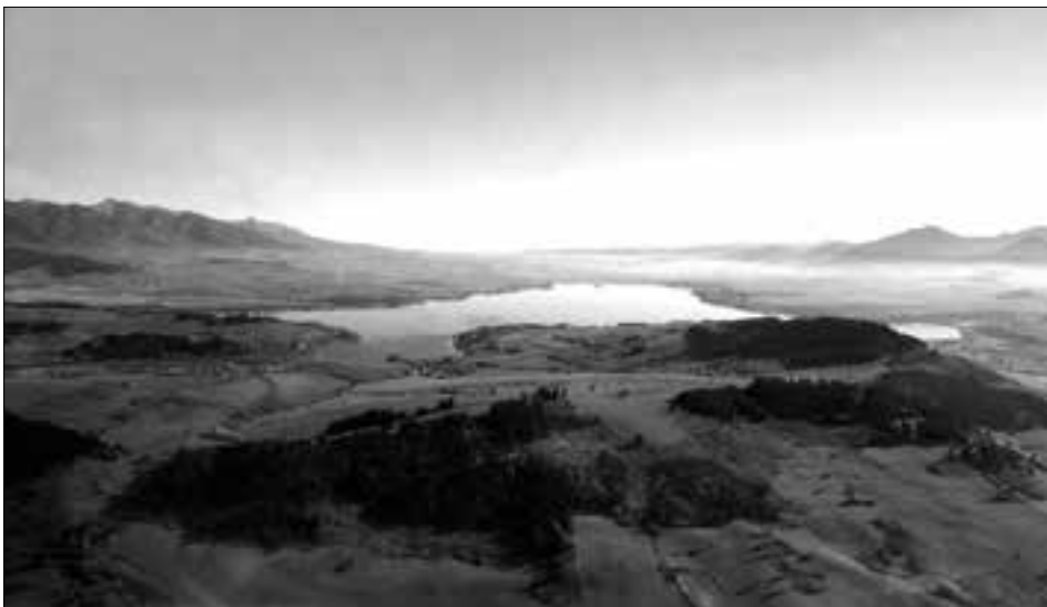
Obr. 1. Celkový pohľad na VD Liptovská Mara v Liptovskej kotline. Foto archív SMOPaJ
