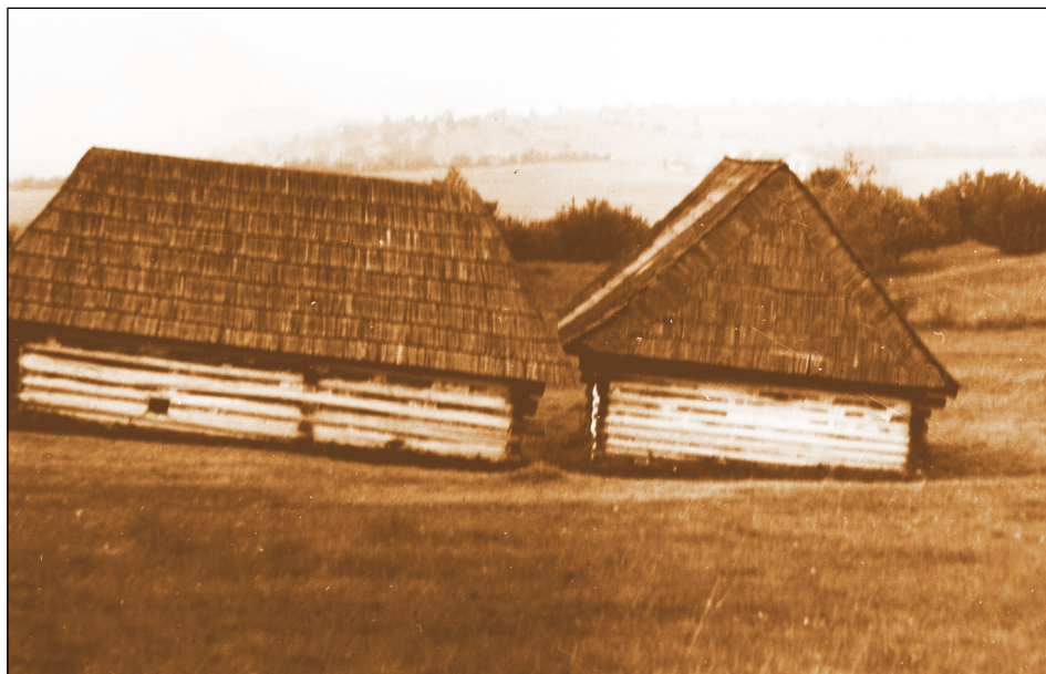
Obr. 7. Poklesávaním dna závrtu naklonené hospodárske budovy v Šumiackom krase. Foto: J. Jakál Fig. 7. The sinking bottom of a doline caused inclination of farm buildings in the karst of Šumiac. Photo: J. Jakál
