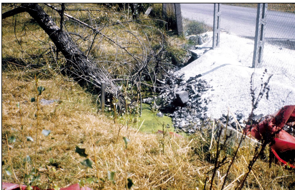
Obr. 8. Prepadnutie stropov jaskynných dutín a vznik zrúteného závrtu s prepadnutím cesty (čiastočne zrekonštruovanej) na úpätí vrchu Drienok (Horná Nitra) akcelerované dopravou. Foto: J. Jakál Fig. 8. Collapse of cave cavity ceiling and the origin of the collapsed doline with foundered road (partially reconstructed) at the foothill of the Drienok Mt. (region of Upper Nitra) accelerated by traffic. Photo: J. Jakál
