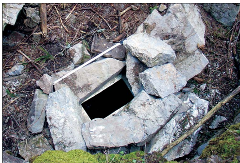
Obr. 9. Zamaskovaný uzáver Objavného vchodu s vletovým otvorom pre netopiere. Foto: Z. Višňovská Fig. 9. Masked closing in the upper opening with outlet for bats. Photo: Z. Višňovská
