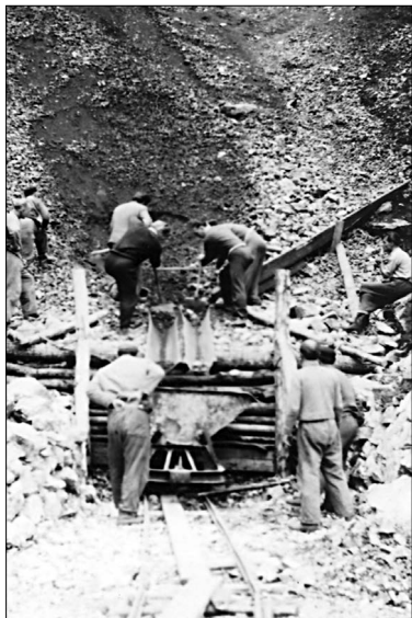
Obr. 4. Krasový prameň Vízavat. Nakladanie sutiny priamo zo svahu strže pomocou rozpolenej rúry do banského vozíka typu kačák
