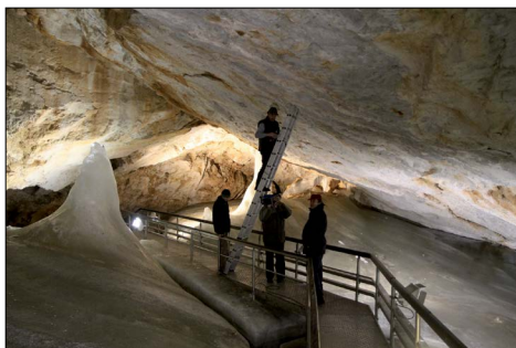
Obr. 2. Stabilizácia meračského bodu v Malej sieni. Foto: J. Gašinec
