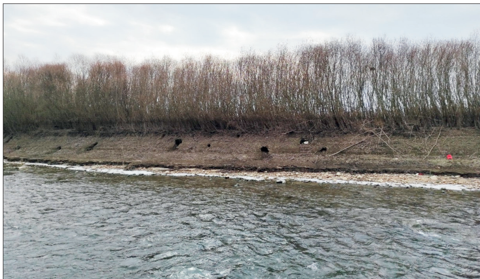
Obr. 1. Bobrie nory na ľavom brehu Váhu v opakovane zaplavovanej vtokovej časti priehrady Liptovská Mara. Foto: P. Bella, február 2025
