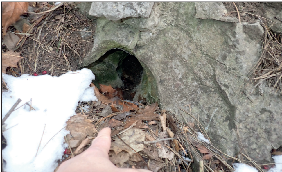
Obr. 13. Neprielezné iniciálne kanály v karbonátových horninách. Foto: P. Holúbek Fig. 13. Impassable proto-conduits in carbonate rocks. Photo: P. Holúbek
