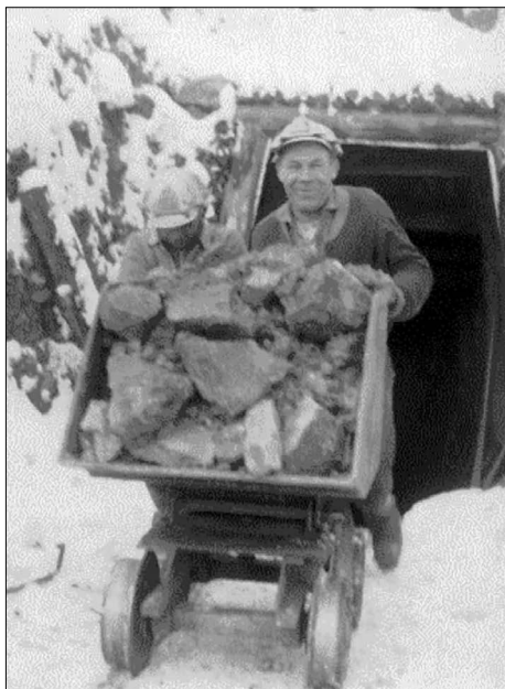
Obr. 5. Prvý umelý vchod do Krásnohorskej jaskyne. Porubový otočne výklopný vozík „kačák“. Foto: V. Zabari
