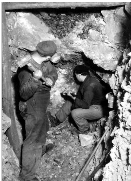
Obr. 3. Ručné vrtanie pri razení umelého vchodu Novej Brzotínskej jaskyne. Foto: V. Rozložník
