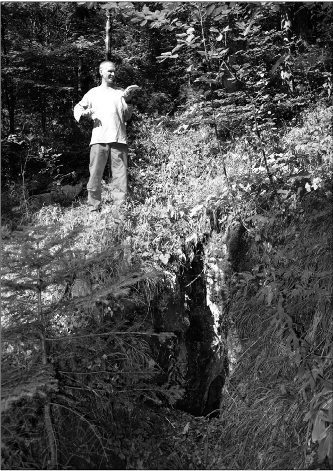
Trhlina na Grúniku. Foto: M. Jagerčík
