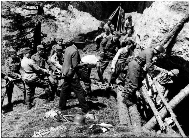
Obr. 3. Technické zabezpečenie prvého zostupu v roku 1939
