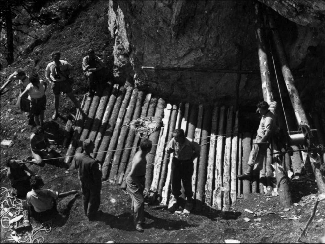
Obr. 10. Prípravné práce pri stavbe rumpálu v roku 1956
