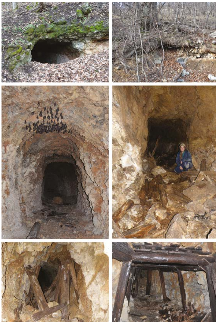
Obr. 2. Štôlne Vajarská I a II: a) vstupný otvor do štôlne Vajarská I, b) vstupný otvor do štôlne Vajarská II, c) ľavá bočná chodba v štôlni Vajarská I, d) hlavná chodba v štôlni Vajarská I, e) hlavná chodba v štôlni Vajarská II, f) úsek chodby s ešte zachovalou výdreovou v štôlni Vajarská II. Foto: B. Lehotská, R. Lehotský
